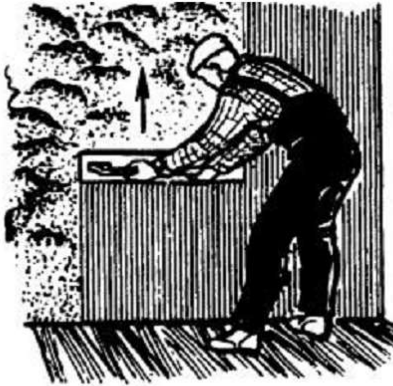
Рис. 2. Разравнивание раствора полутерком.
